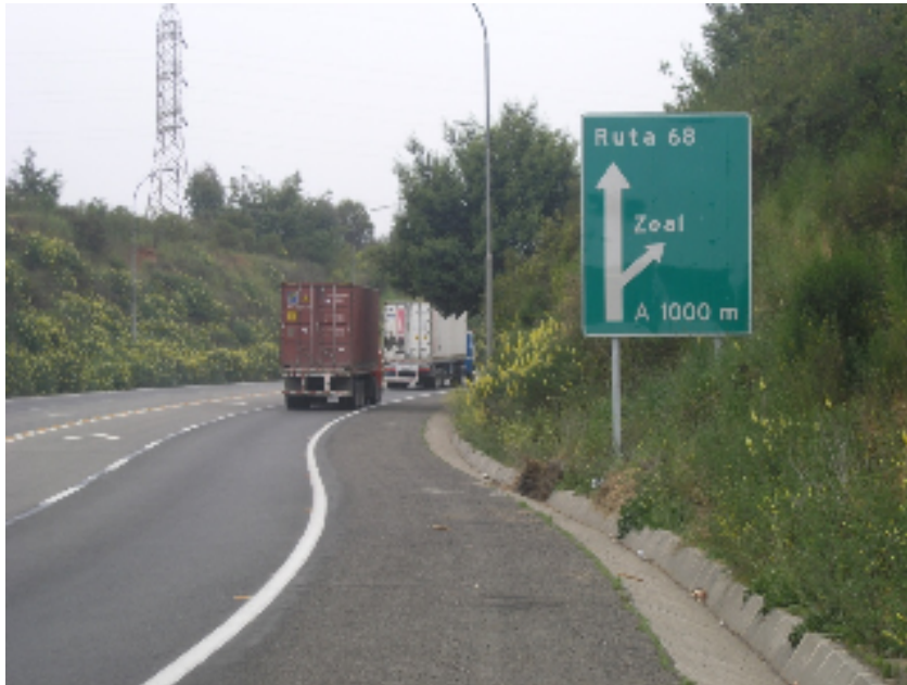
Instaladas en puntos de acceso y bifurcaciones
