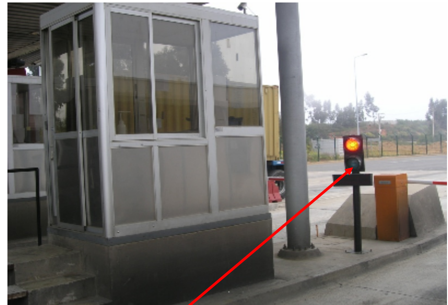
Panel Variable indica Zona de Parqueo
